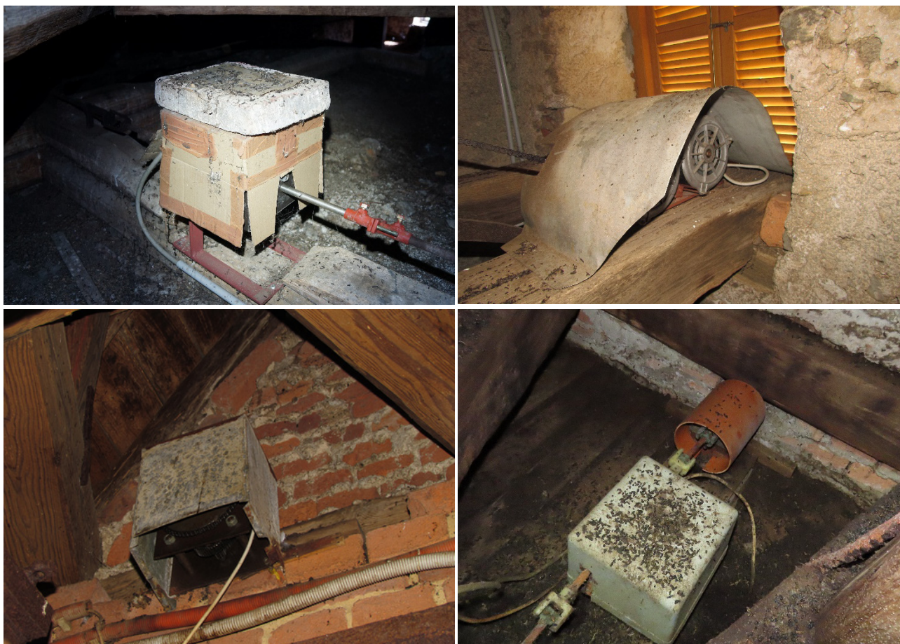
Slika 16: Primeri »naredi sam« zaščit, ki so jih upravljalci postavili, da bi preprečili obremenjenost elektromotorjev in zobnikov urnega mehanizma z netopirskim gvanom (cerkve na Igu, Blečjem vrhu, Kobilju, Mežici, izvedba upravljalca). (foto: Aja Zamolo, Primož Presetnik)
