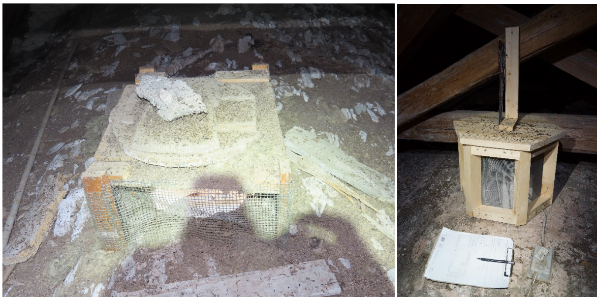
Slika 15: Rešitev, ki preprečuje padanje gvana v cerkveno ladjo skozi odprtino za lestene (cerkvi v Lazcu in Jakovici, izvedba upravljalca oz. v projektu KRAS.RE.VITA ). (foto: Primož Presetnik, Aja Zamolo)
