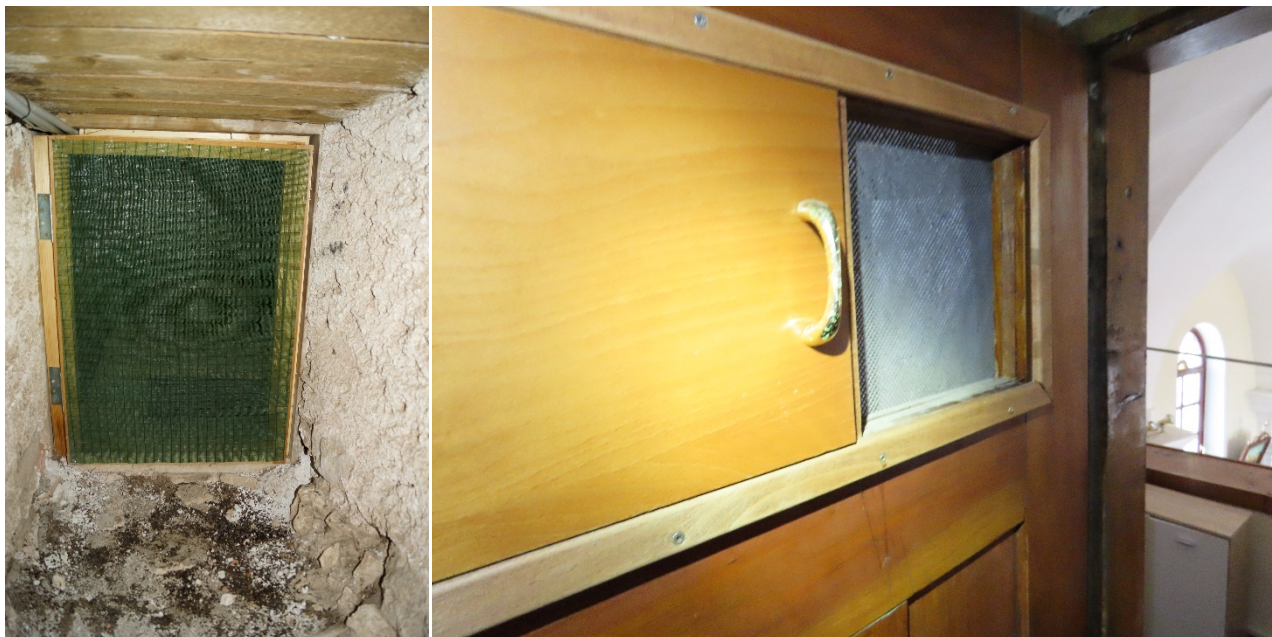
Slika 19: Primer zaprtja prehoda iz kora na podstreho s popolnoma mrežastimi vrati ali vrati, ki imajo poleg zamreženega okna tudi loputo, ki se pozimi zapre (varčevanje s toploto). Zračenje je v obeh primerih zagotovljeno, netopirji pa se v fine mreže ne morejo zaplesti (cerkvi v Bočni in veliki Ligojni, izvedba upravljalce). (foto: Aja Zamolo, Primož Presetnik)
