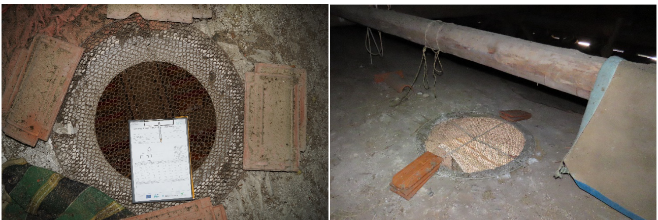
Slika 14: Primer zaščite pred vstopom netopirjev skozi odprtino za lestenev v cerkevno ladjo, na desni sliki se vidi tudi preproga, s katero verjetno zaradi toplotne izolacije pozimi pokrijejo odprtino (cerkvi v Dolenjih Novakih in v Cerknem, izvedba upravljalec). (foto: Aja Zamolo, Primož Presetnik)
