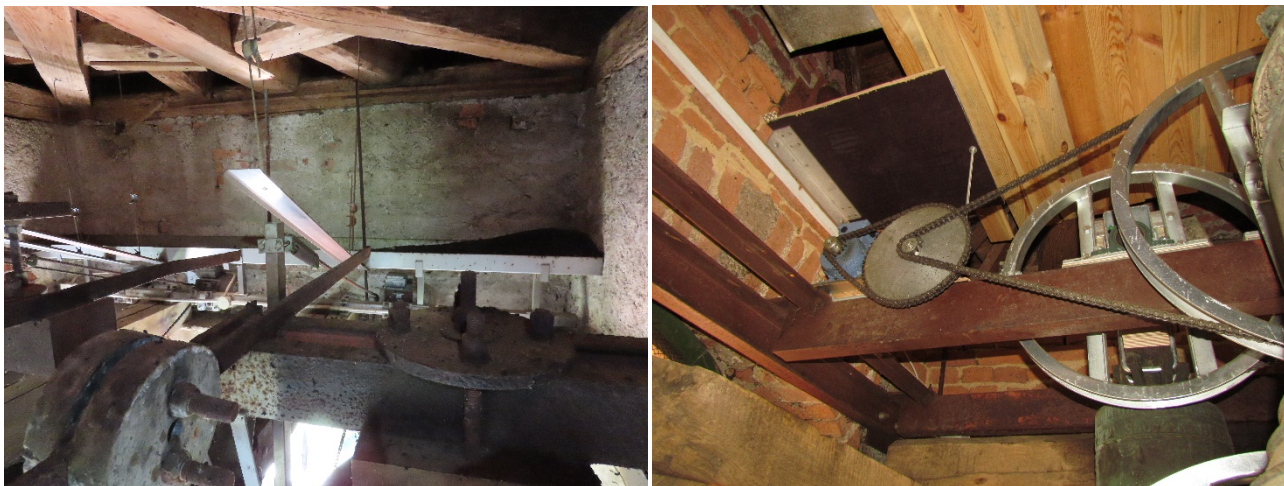
Slika 17: Zaščita verig in ostalih pogonskih mehanizmov zvonov z aluminijastimi profili ali pa leseno polico (cerkvi v Goriči vasi in Kobilju, izvedba v projektu Navadni netopirji – prav posebni sosedge! oz. javna služba). (foto: Primož Presetnik)
