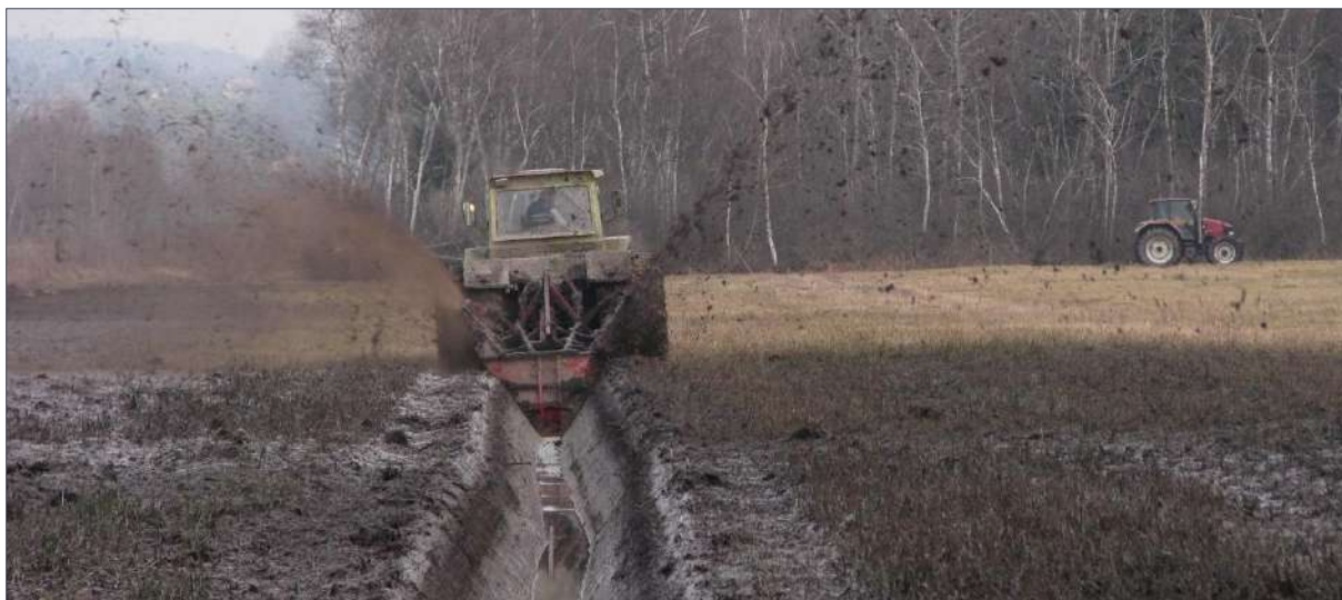
Slika 17: Vrezovanje osuševalnega jarka na Ljubljanskem barju v bližini reke Iščice. Sodobna tehnologija omogoča enostavno obnavljanje in vrezovanje novih osuševalnih jarkov, ki so čedalje globlji in vse širši. Foto: Tomaž Jančar.
