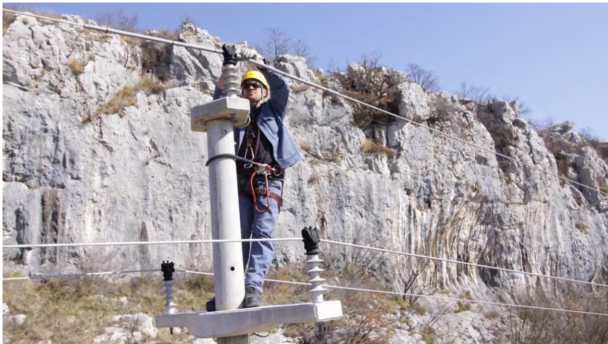
Slika 5. Sanacija novogradnje daljnovoda s pomočjo izolacije vodnikov in izolativne kapice izolatorjev, 1.3.2012 (foto: T. Mihelič).
