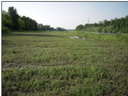
Slika 67: Osrednji del sipine št. 4 po vzdrževalnih delih, izvedenih med sezonama 2011 in 2012. (foto: L. Božič)
