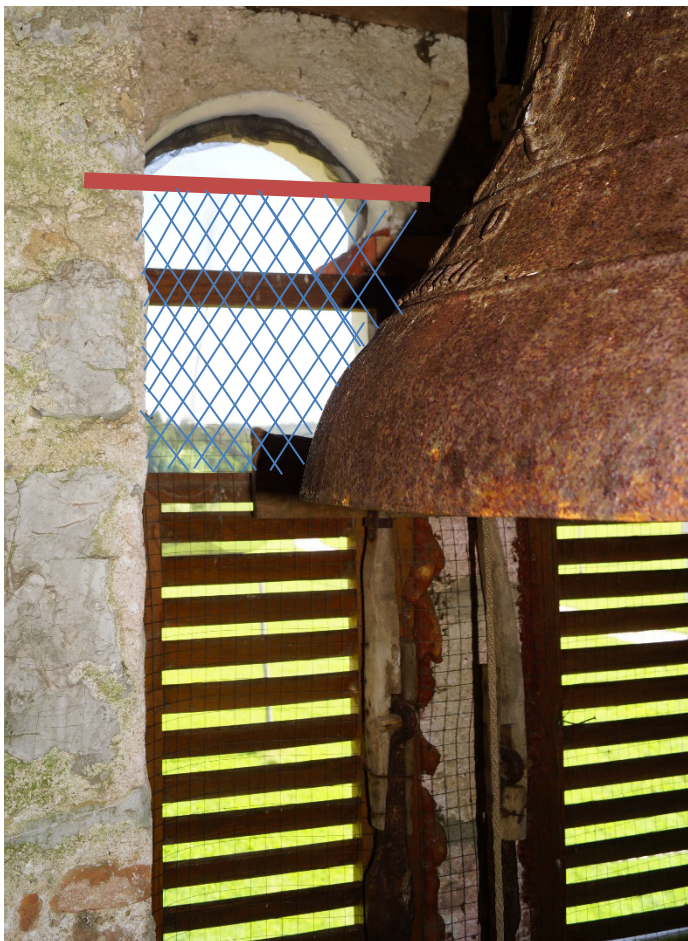
Slika 6: Predlog preletne odprtine ob zvonišču – rdeča linija označuje mesto, kjer naj se močnejša mreža konča (7 cm pod obokom okna).
