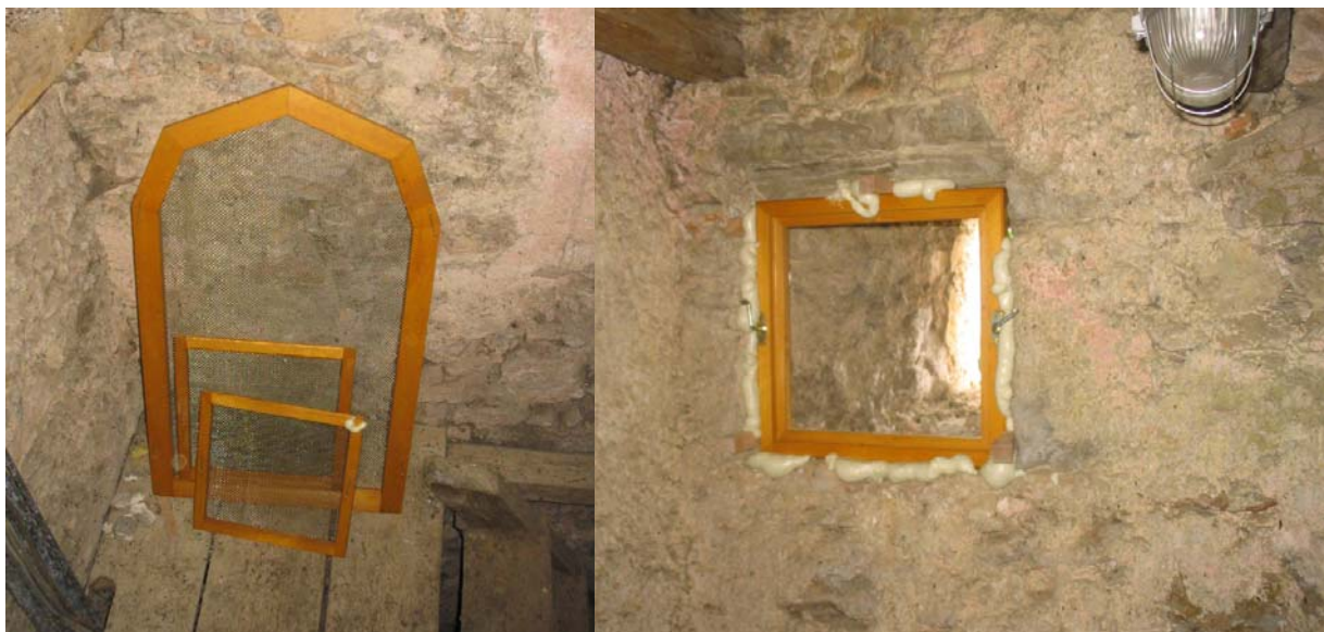
Slika 11. Pripravljene mreže in okvirji za namestitev na preletne odprtine netopirjev. (foto: P. Presetnik; 6.6.2008)
