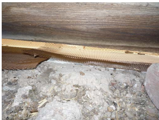
Slika 23. Zamrežene reže med zidom in streho so onemogočile zadnji vstop malim podkovnjakom (foto: David Stanković, 30.6.2010).
