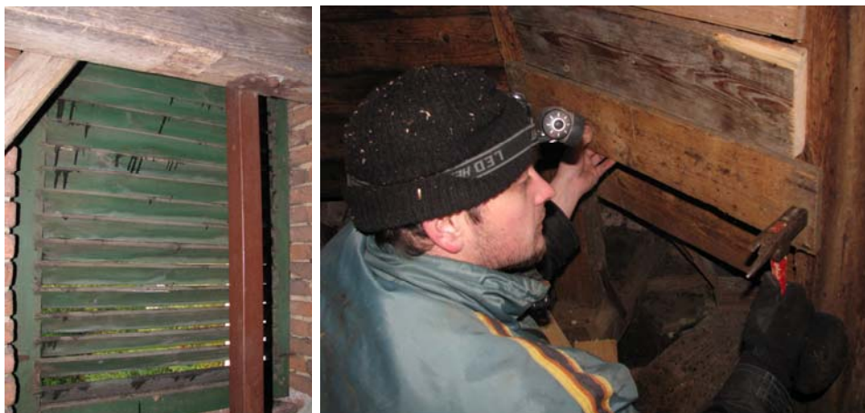
Slika 8. Decembra 2009 je bila iz enega polkna pri zvonovih odstranjena mreža (levo), nad zvonovi pa nameščene grobo obdelane deske, ki bodo lahko služila za visišča navadnim netopirjem (desno) (foto: Monika Podgorelec, 23.12.2009).
