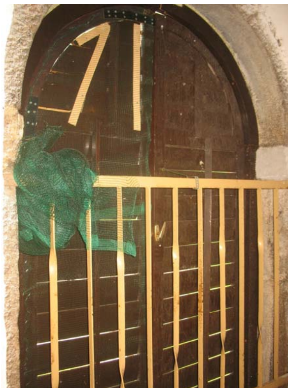
Slika 16. Na pol nameščene plastične mreže na notranji stani polken na zvonišču cerkve sv. Marije Vnebovzete v Dolenji Straži (foto: Primož Presetnik 10.9.2010).
