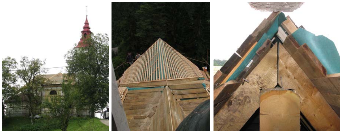
Slika 25. Obnova ostrešja cerkve sv. Petra v Vintarjevci je bila 10.9.2010 v večji meri že izvedena. Streha je bila obnovljena tako, da ima zračni most, kjer se na tramove opaži z deskami, nanje pa se položi paraprepustno folijo (foto: Monika Podgorelec, 10.9.2010).
