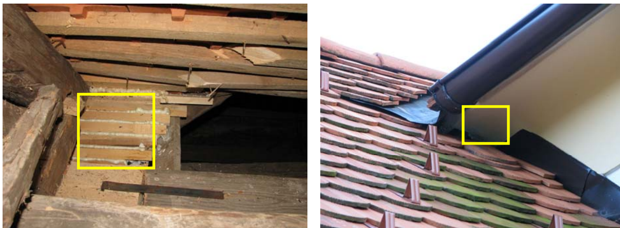
Slika 13. Lina L2 na strešnem vencu ob sprednji strehi zakristije na severni strani cerkve je bila tudi letos še vedno zaprta (levo-pogled iz notranjosti cerkve, desno-pogled od zunaj). Z ukrepom (B) se mora vzpostaviti odprtina L2 v dimenzijah ca. 30 cm x 20 cm (rumeni okvir na sliki) (foto: Monika Podgorelec, 15.8.2010).
