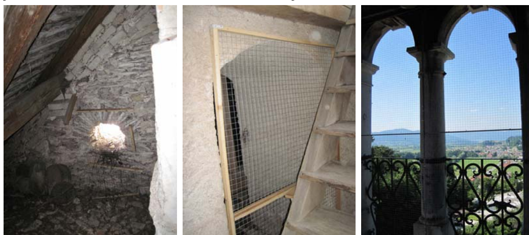
Slika 22. Zamrežena okrogla preletna odprtina malih podkovnjakov; z neustreznimi rešetkami pregrajen prehod med podstreho in zvonikom ter zamrežene line na zvonišču in nad njim lahko negativno vplivajo na navadne netopirje (foto: Primož Presetnik, 25.6.2010).
