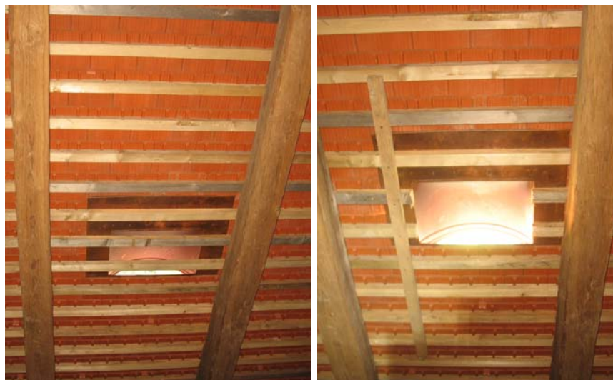
Slika 15. "Zračniki" oz. "netopirske odprtine" na SV strani strehe cerkve sv. Peter in Pavel v Brestanici so bili do konca marca 2010 pregrajeni s strešnimi letvami (foto: Primož Presetnik, 27.6.2009 in 10.8.2010).
