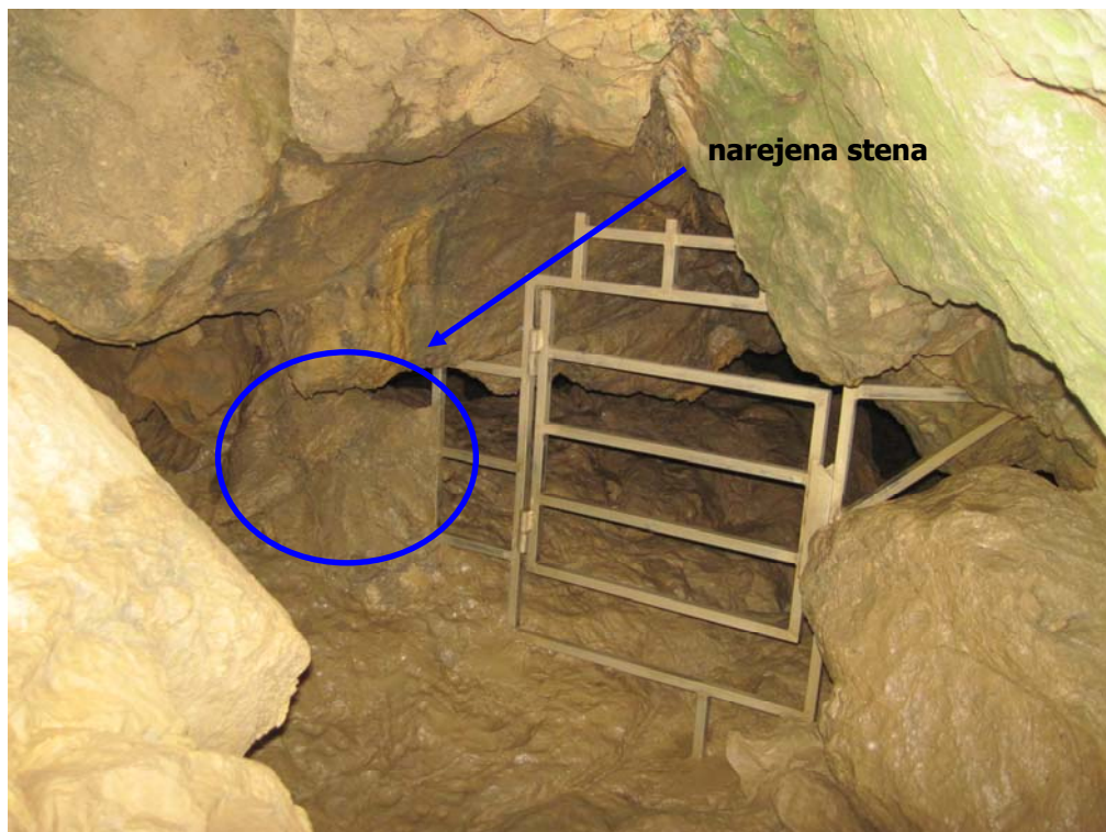
Slika 18. Označen novo narejen del stene na vhodu v Osapsko jamo (foto: Primož Prešetnik, 27.6.2010).
