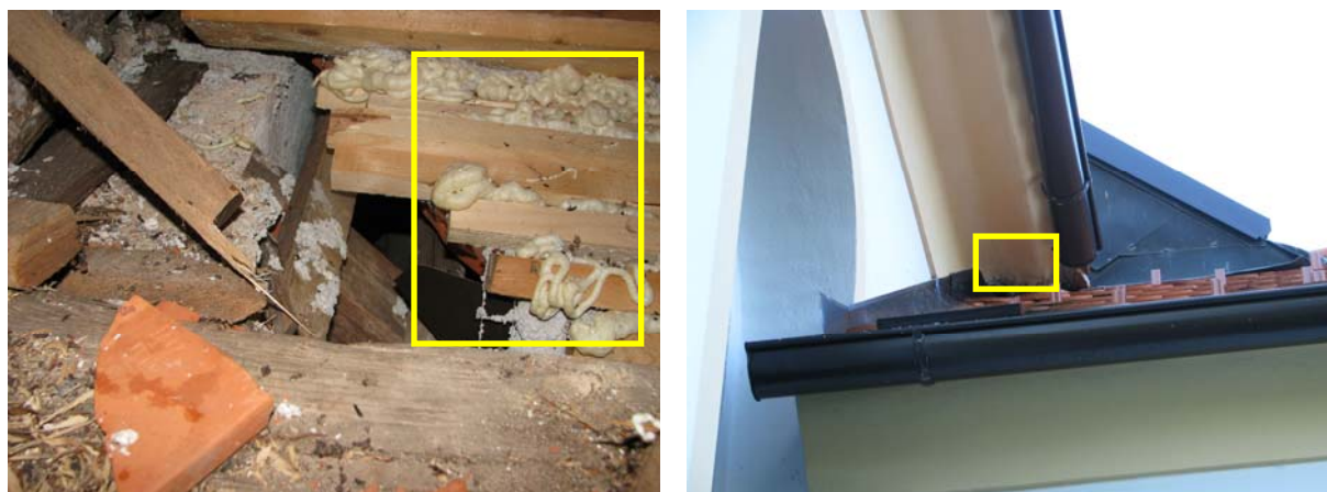
Slika 12. Lina L1 na strešnem vencu ob zadnji strehi zakristije na severni strani cerkve je bila tudi letos še vedno zaprta (levo-pogled iz notranjosti cerkve, desno-pogled od zunaj). Navidezna odprtina trenutno vodi v podstreho zakristije (levo), povezave z zunanostjo ni (desno). Z ukrepom (B) se mora vzpostaviti odprtina L1 v dimenzijah ca. 30 cm x 20 cm (rumeni okvir na sliki) (foto: Monika Podgorelec, 15.8.2010).
