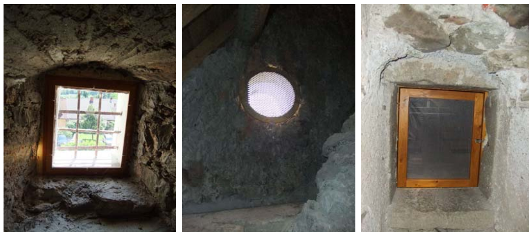
Slika 21. Zamenjava polomljenih stekel na odprtinah v zvoniku do zvonov (levo) in zamreženje okroglih odprtin na podstrehi (sredina) ter prehoda med zvonikom in podstreho (desno) v cerkvi sv. Petra v Selcih je uničilo kotišče malih podkovnjakov (foto: Monika Podgorelec, 24.6.2010).
