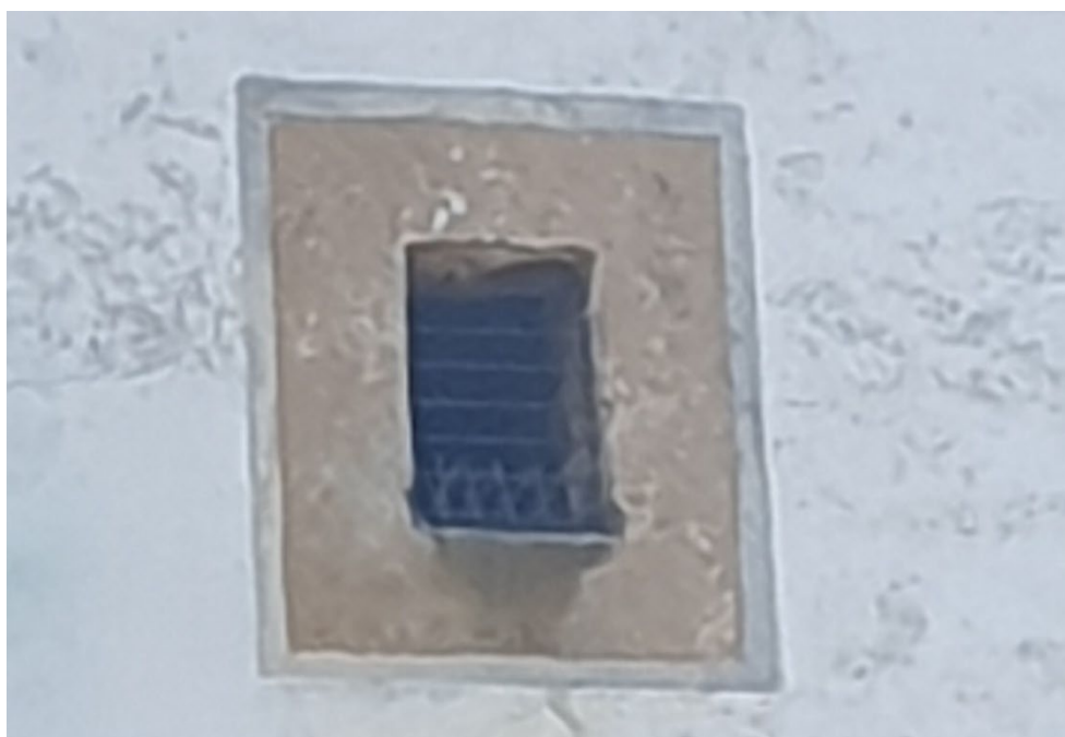
Slika 10: Nameščene žice za preprečevanje vstopa golobov, na preletnice netopirjev v cerkvi Device Marije na Pesku, Slake (foto: Toni Preskar).
