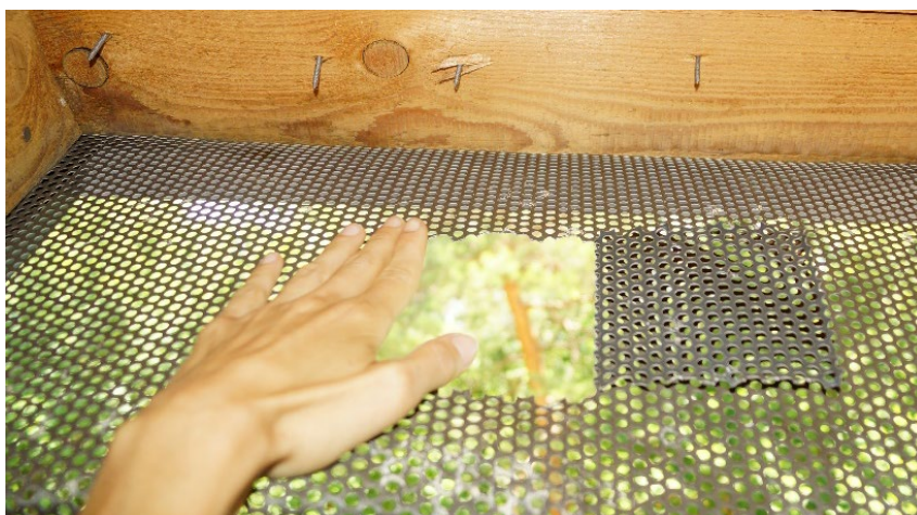
Slika 9: Izrezana preletna odprtina na zamreženem zračniku podstrehe cerkve sv. Neže na Brinjevi gori (foto: Aja Zamolo).
