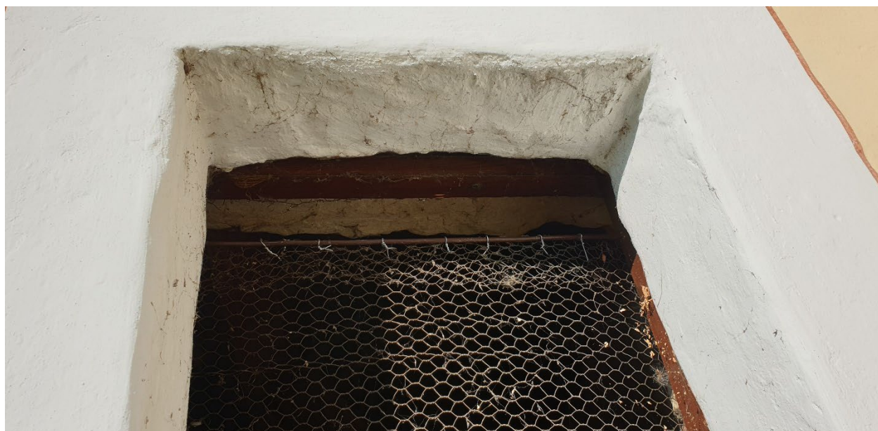
Slika 7: Odvihan vrhnji del mreže na oknu na podstrehi sv. Filip in Jakob v Selah (foto: Toni Preskar).
