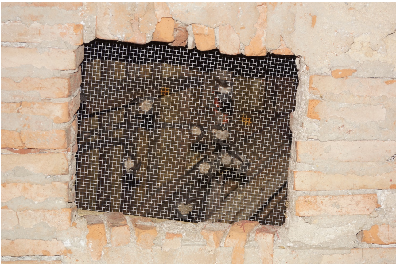
Slika 18. Mreže nameščene na prehod nad zvoniščem v prostor nad zvonovi (pogled od spodaj) in v njih zatakljena trupla malih podkovnjakov (foto: Aja Zamolo, 23. 6. 2023).
