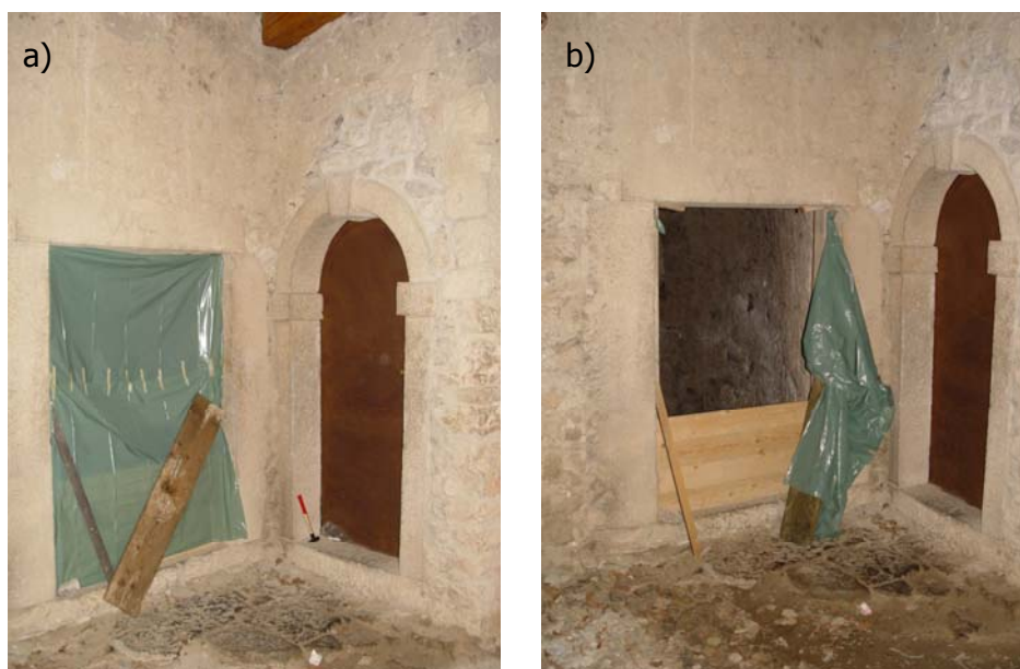
Slika 71. a) Zastrt vhod v vhodni stolp 22. maja in b) odstranjena ponjava 6. junija 2007 (foto. P. Presetnik)
