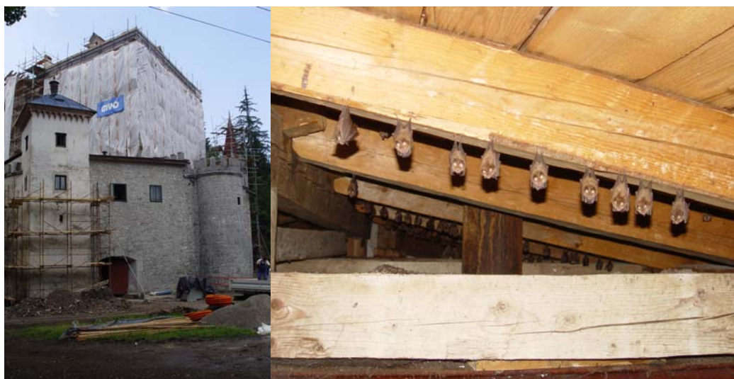
Slika 67. Vzhodni trakt grada Snežnik in porodniška gruča malih podkovnjakov na podstrehi (foto: P. Presetnik 25.7. 2006)
